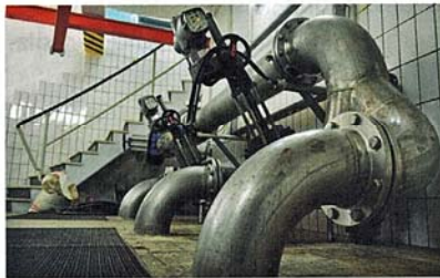
Eine optimierte Visualisierung aller Betriebszustände erleichtert die schnelle und sichere Lageeinschätzung durch die SAL-Mitarbeiter.
